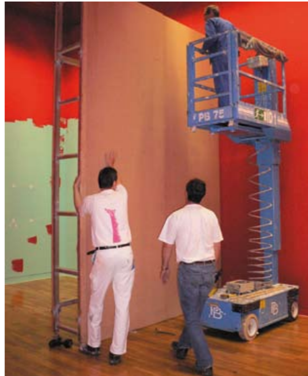
Bepankung der Innenkonstruktion mit z. B. 13 mm Tischlerplatten
