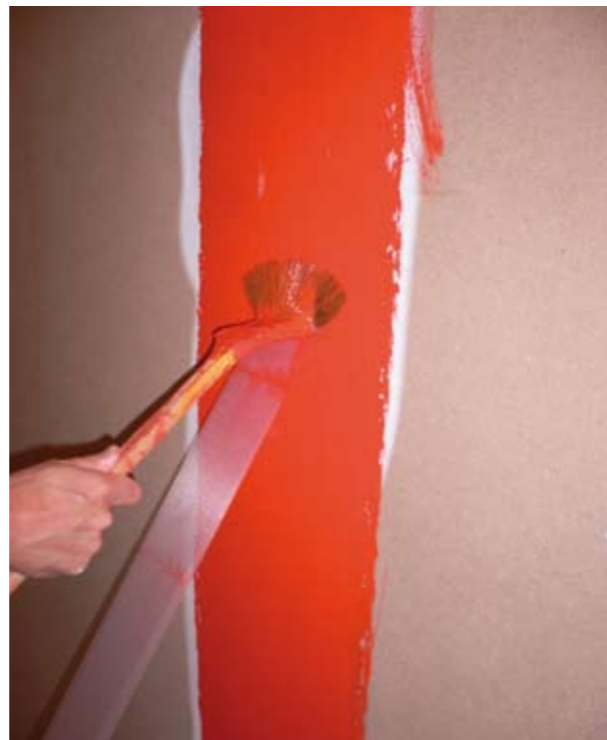
eines breiten Pinsels ein Gewebband in die noch frische Farbe eingelegt. Letztlich erfolgt der Anstrich der gesamten Wandoberfläche mit z. B. Dispersionsfarbe
