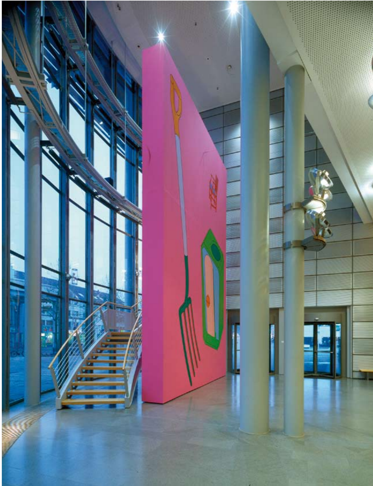
Errichtung einer freistehenden Wand in einer Sonderhöhe von 8 m
