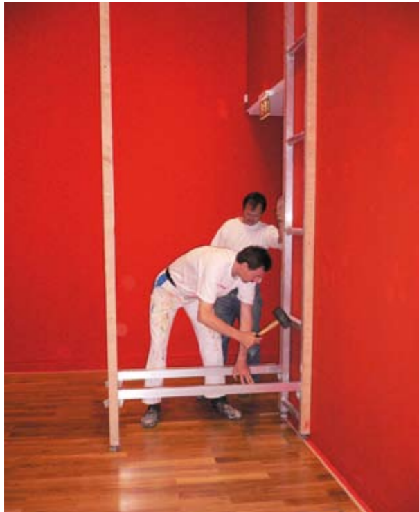
Aufstellen der Aluminium-Innenkonstruktion und Zusammenbau der Bauteile mit Hilfe eines Gummihammers
